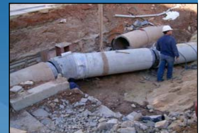
Montaje tubería desvío línea 5 Metro
