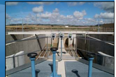
EDAR de Tordesillas
